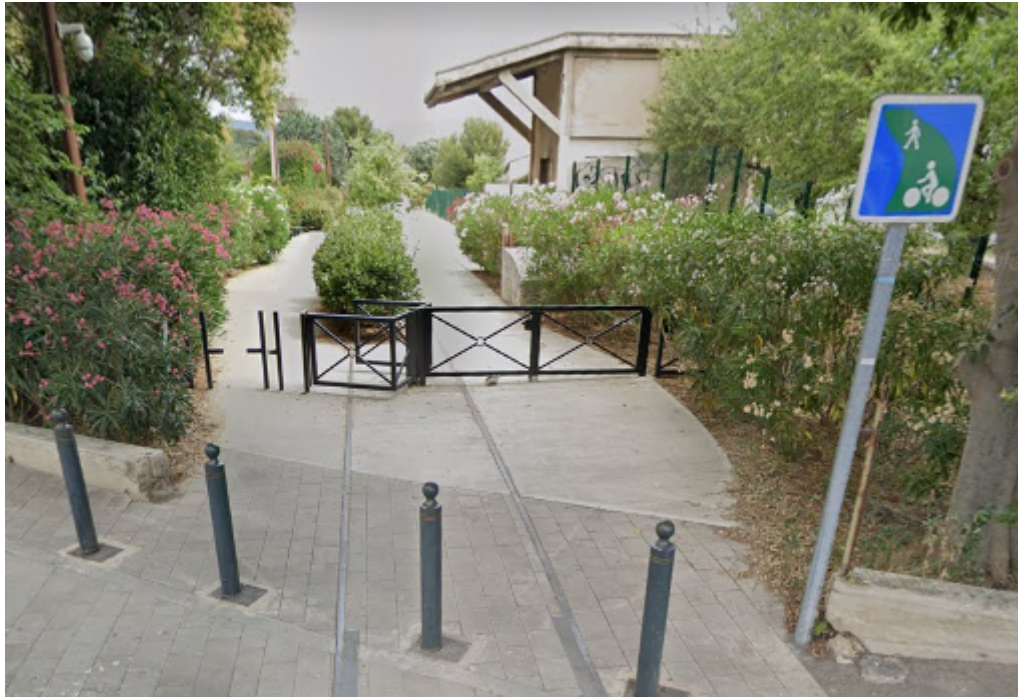
Tranche 1 de la "voie douce": dispositif anti-accès motorisé déconseillé par le Cerema (on notera les autres moyens anti-motorisés en service - suffisants à notre avis-: signalisation, potelets, vidéosurveillance et patrouilles de police municipale)
